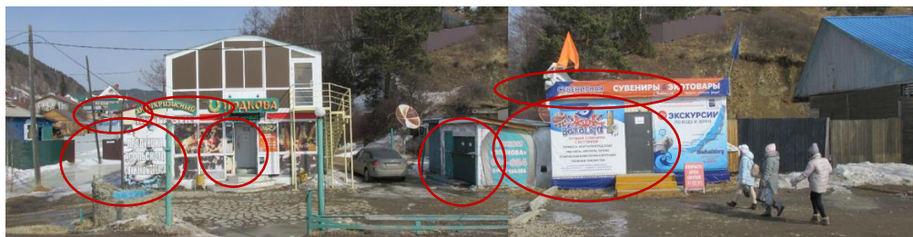
Рис. 18. Самостоятельные надстройки, многочисленные вывески, ул. Горького, 59а, 59б Fig. 18. Independent superstructures, numerous signs, Gorky St., 59a, 59b
