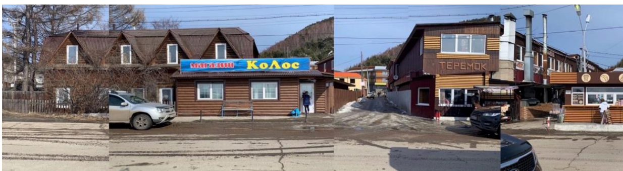
Рис. 7. Административное здание, магазин «Колос», кафе «Теремок», ул. Горького, 109 Fig. 7. Administrative building, shop "Kolos", cafe "Teremok", Gorky St., 109
