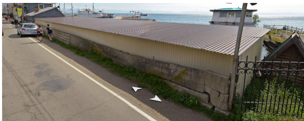
Рис. 14. Отсутствие тротуаров, ул. Горького, 2/1 Fig. 14. Lack of sidewalks, Gorky St., 2/1
