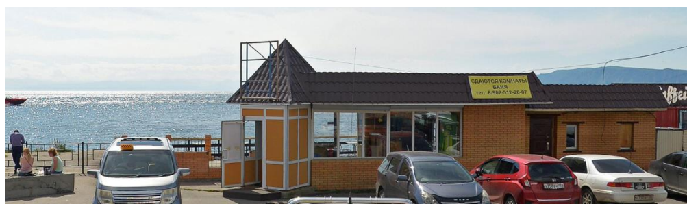
Рис. 19. Дефицит озелененных территорий, ул. Горького, 85а Fig. 19. Lack of green areas, Gorky St., 85a
