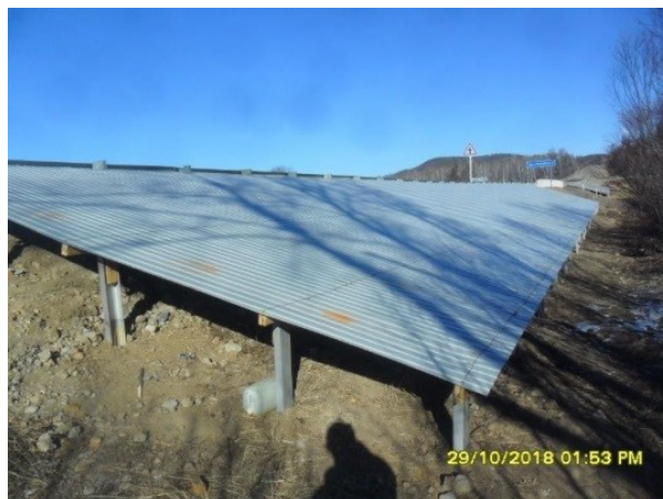
Рис. 5. Устройство солнцезащитных навесов Fig. 5. Installation of sun protection canopies
