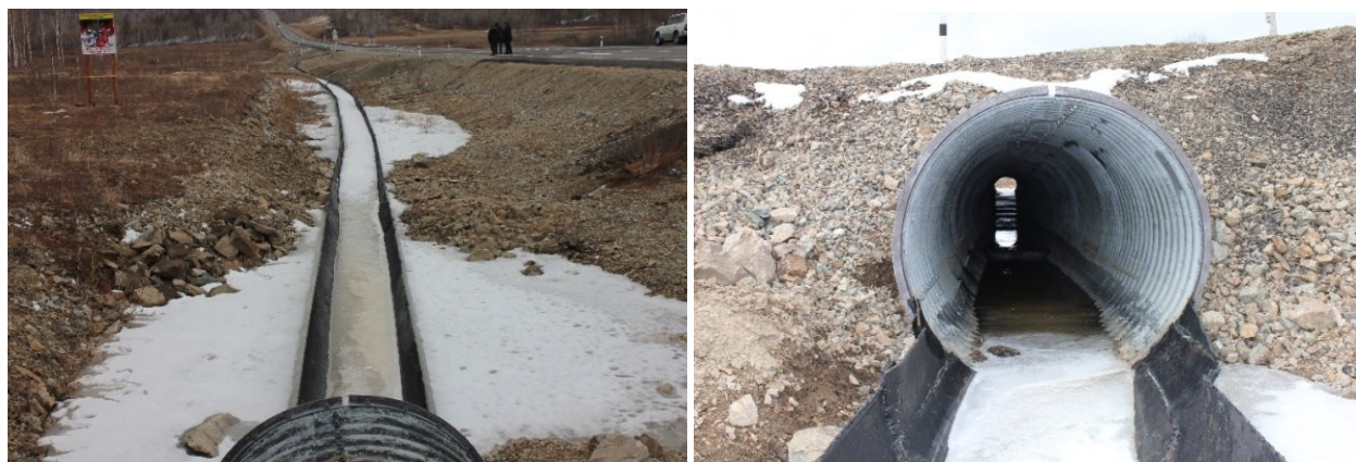
Рис. 3. Укрепление кювета с помощью укладки на дно металлической трубы Fig. 3. Strengthening the cuvette by laying a metal pipe on the bottom
