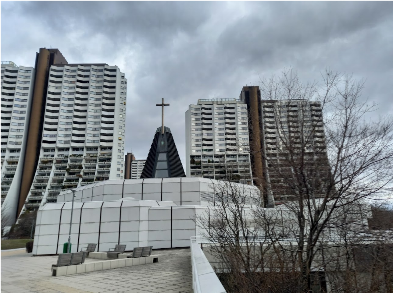
Рис. 4. Pfarre Wohnpark Alterlaa. Вена, 23-й район, улица Антона Баумгартнера, 44 Fig. 4. Pfarre Wohnpark Alterlaa. Vienna, 23rd district, Anton-Baumgartner-Str., 44
