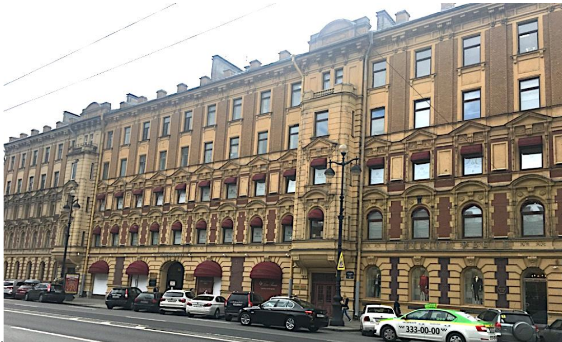
Рис. 3. Л.П. Шишко, А.А. Венсан. Доходный дом (Невский проспект, дом 153). Фото автора Fig. 3. L.P. Shishko, A.A. Vincent. Apartment building (153 Nevsky Prospekt). Photo of the author
