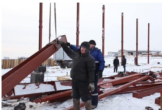
Рис. 2. Монтаж металлических конструкций в зимний период года Fig. 2. Installation of metal structures in winter
