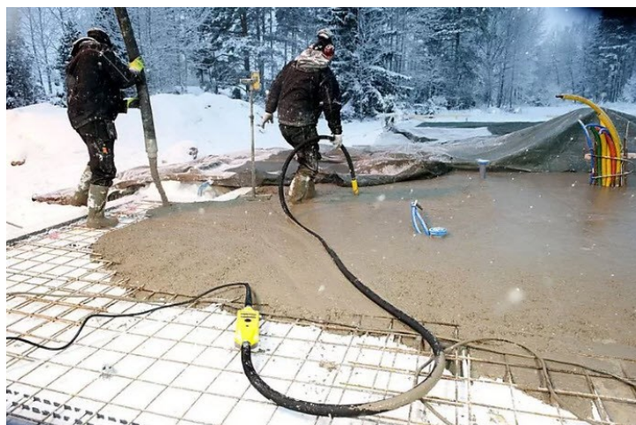
Рис. 3. Применение специальных противоморозных добавок Fig. 3. Application of special antifreeze additives
