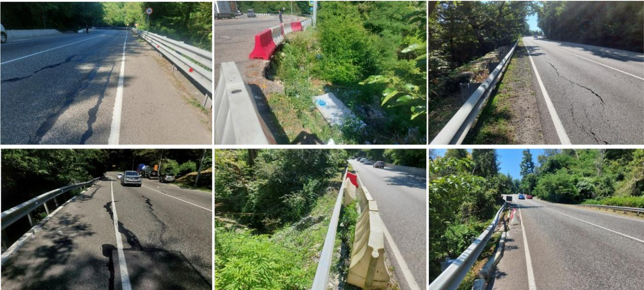
Рис. 2. Визуальное обследование удерживающего сооружения и оползневого участка
