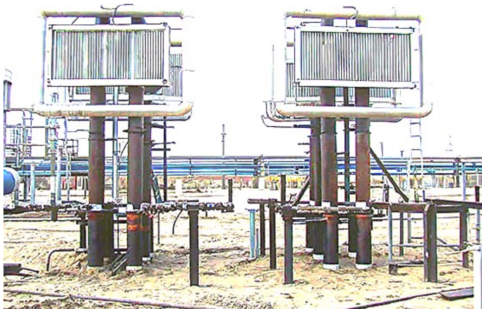
Рис. 3. Автономная система горизонтальной термостабилизации Fig. 3. Autonomous horizontal thermal stabilization system
