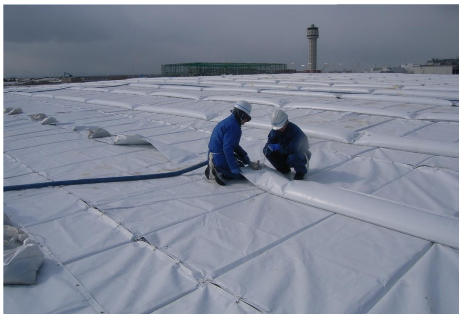
Рис. 4. Процесс монтажа утеплителя снегохранилища в аэропорту г. Титосе (Япония) Fig. 4. The process of installing insulation for a snow storage facility at Chitose Airport (Japan)
