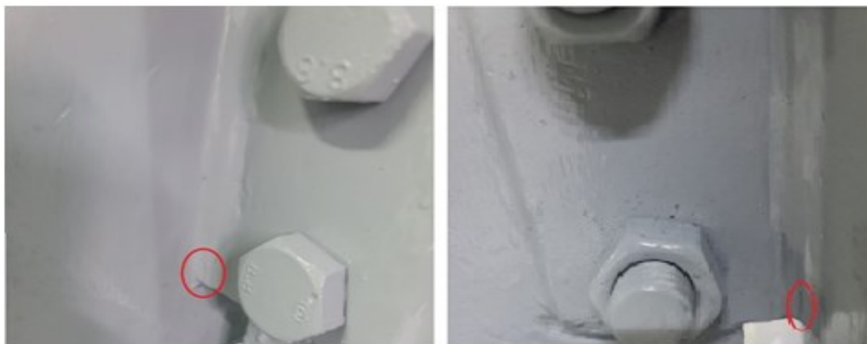
Рис. 5. Разрушения на образце с катетом шва 8 мм Fig. 5. Fracture of the specimen with an 8 mm weld leg
