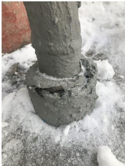
**Рис. 2.** Разрушающийся футляр на вводе в здание в г. Ангарске
