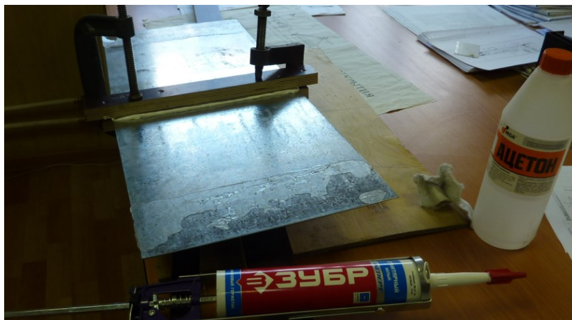
Рис. 8. Соединение металлической гидрошпонки при помощи струбцины Fig. 8. Connecting a metal waterstop with a clamp
