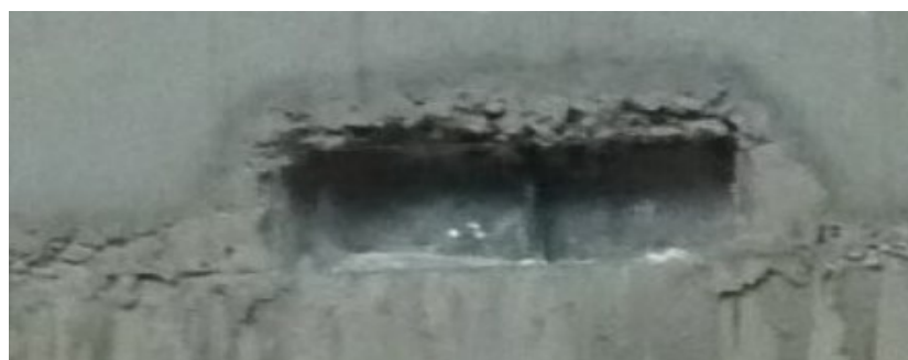
Рис. 15. Герметичный шов металлической гидрошпонки без стыка
