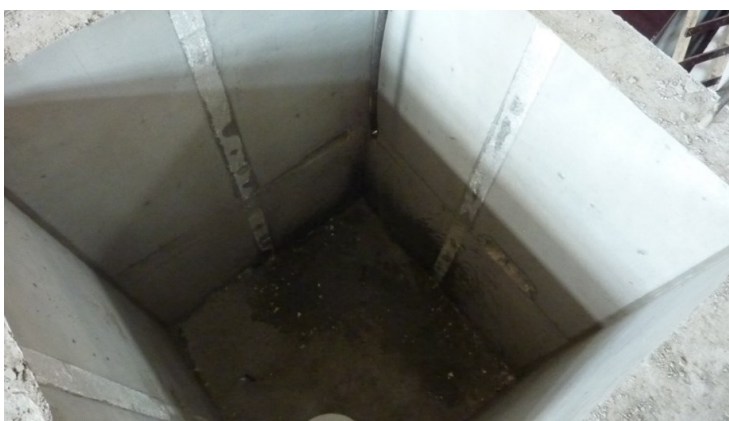
Рис. 12. Наполнение бетонной емкости водой на высоту 2 м Fig. 12. Filling a concrete tank with water to a height of 2 m
