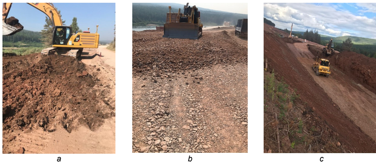
Рис. 2. Строительная техника, оснащенная 3D-системой автоматического управления дорожно-строительными машинами: а – выемка непригодного грунта до проектных отметок; б – отсыпка дорожной одежды до проектных отметок; с – устройство выемки экскаватором до проектных отметок
