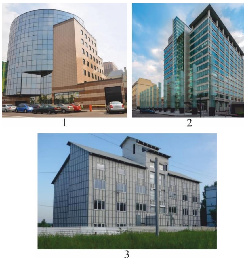
Рис. 1. Экологически сертифицированные здания в России: 1 – бизнес-центр «Японский дом»; 2 – офисное здание Ducat Place III ; 3 – «Дом надежды»
