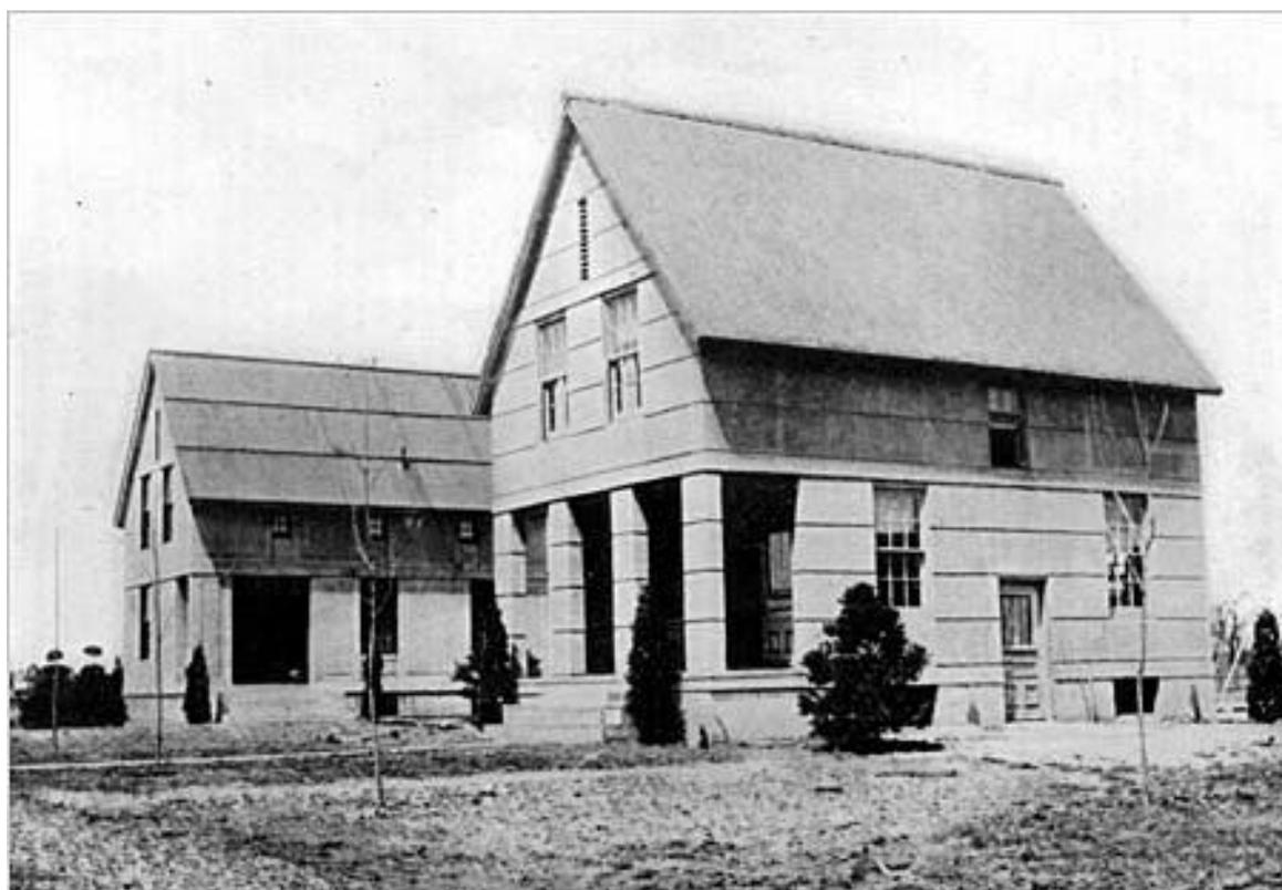
**Рис. 3.** Один из экспериментальных бетонных домов Г. Аттербери в Сьюарене, штат Нью-Джерси. Фото *Standardized Housing Corporation / The Manufacture of Standardized Houses*
