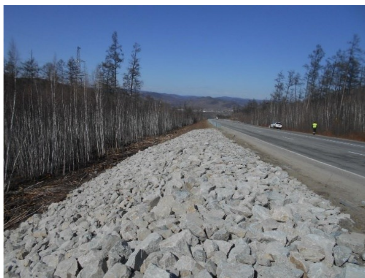
Рис. 4. Устройство каменной наброски на откосных частях земляного полотна насыпи Fig. 4. The device of rock placement on the sloping parts of the subgrade of the embankment
