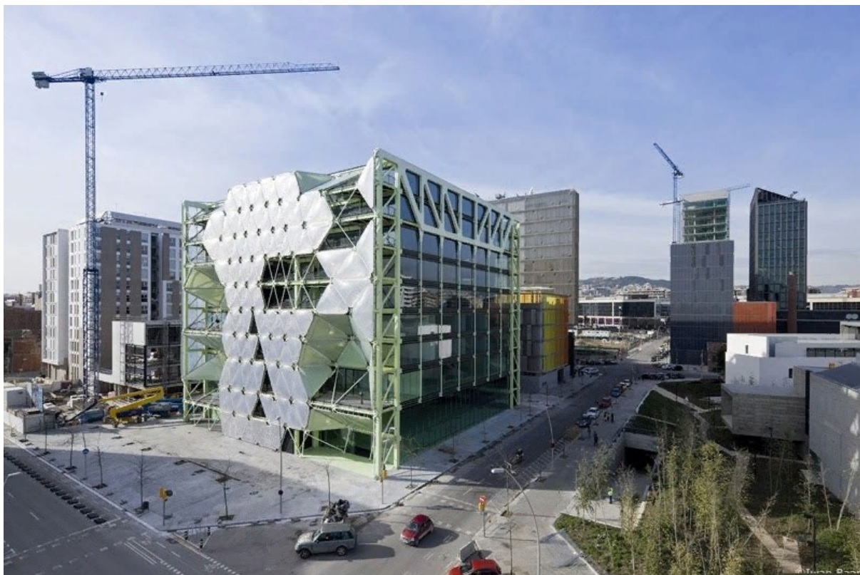
Рис.3. Здание Media-Tic, Барселона, архитектор Энрик Руле-Гели, 2009 г. 4 Fig.3. Media-Tic building, Barcelona, architect Enric Ruiz Geli, 2009
