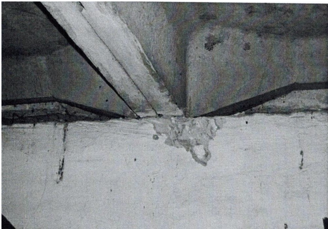
Рис. 7. Фотография ребристых плит перекрытия Fig. 7. Photograph of ribbed floor slabs
