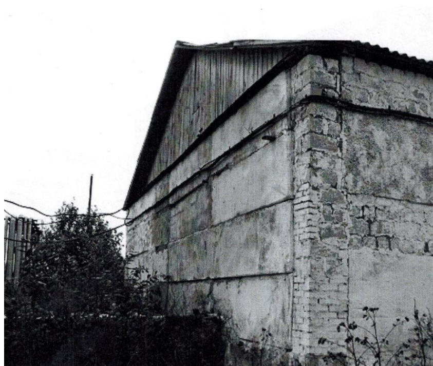
Рис. 3. Фотография фасада здания в осях А–В Fig. 3. Photograph of the building facade in axes A–B
