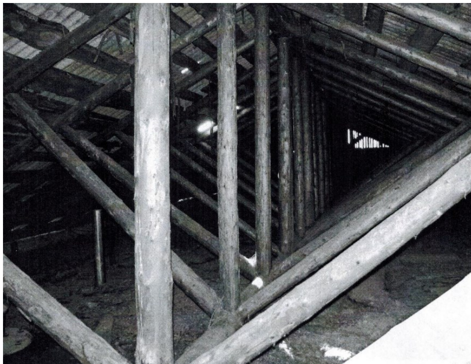
Рис. 6. Фотография стропил Fig. 6. Photograph of the rafters
