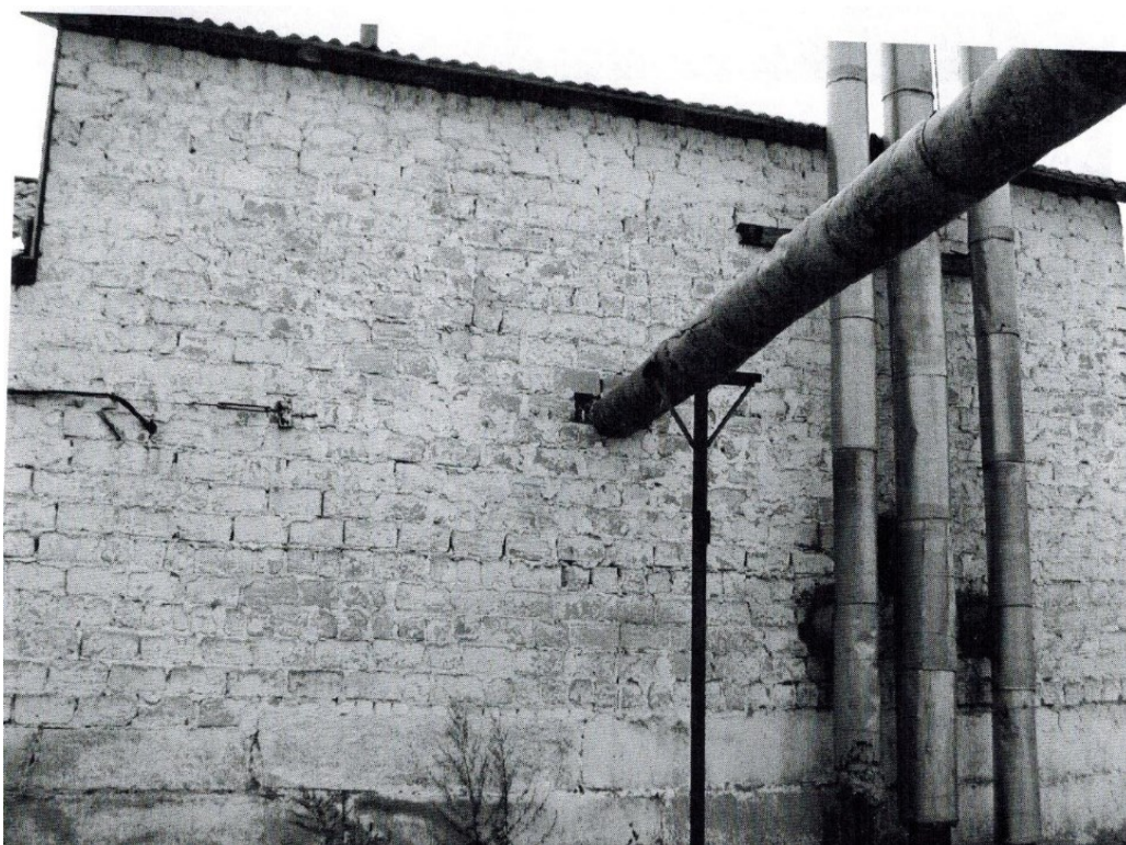
Рис. 9. Фотография стены здания Fig. 9. Photograph of the building wall
