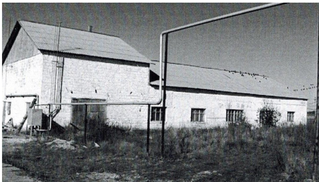
Рис. 1. Фотография фасада здания в осях 1–7 Fig. 1. Photograph of the building facade in axes 1–7
