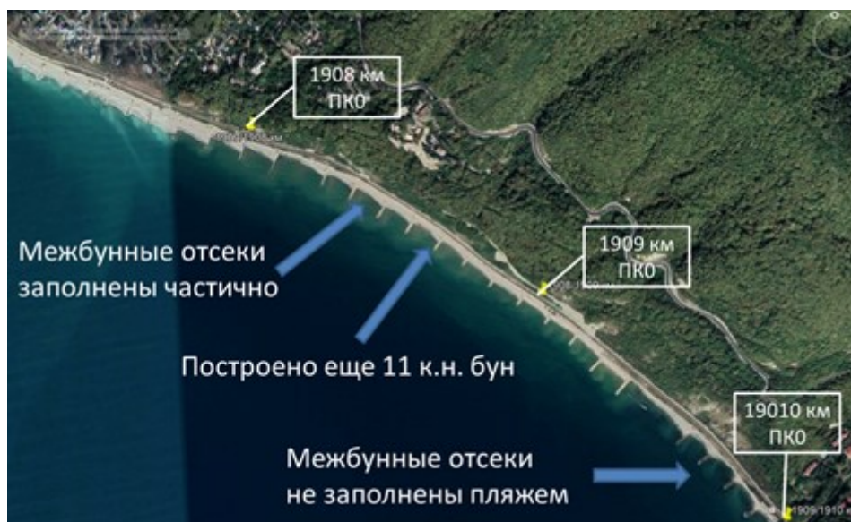
Рис. 6. Состояние волногасящей полосы от 1907 км ПК0 до 1910 км ПК0, 2020 г.
