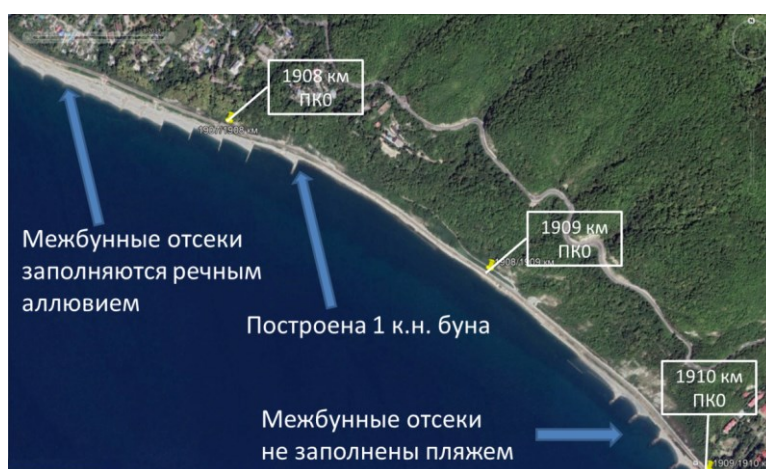
Рис. 3. Состояние волногасящей полосы от 1907 км ПК0 до 1910 км ПК0, 2018 г. Fig. 3. The condition of the beach from 1907 km PK0 to 1910 km PK0, 2018
