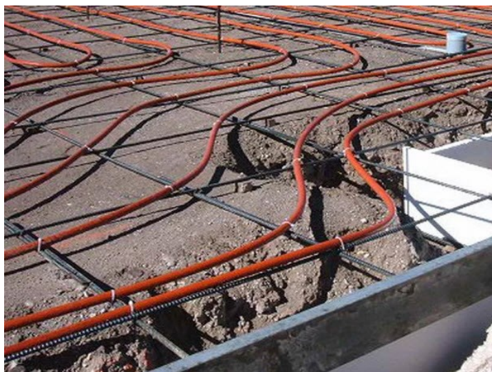
Рис. 4. Электрообогрев бетона Fig. 4. Electric heating of concrete
