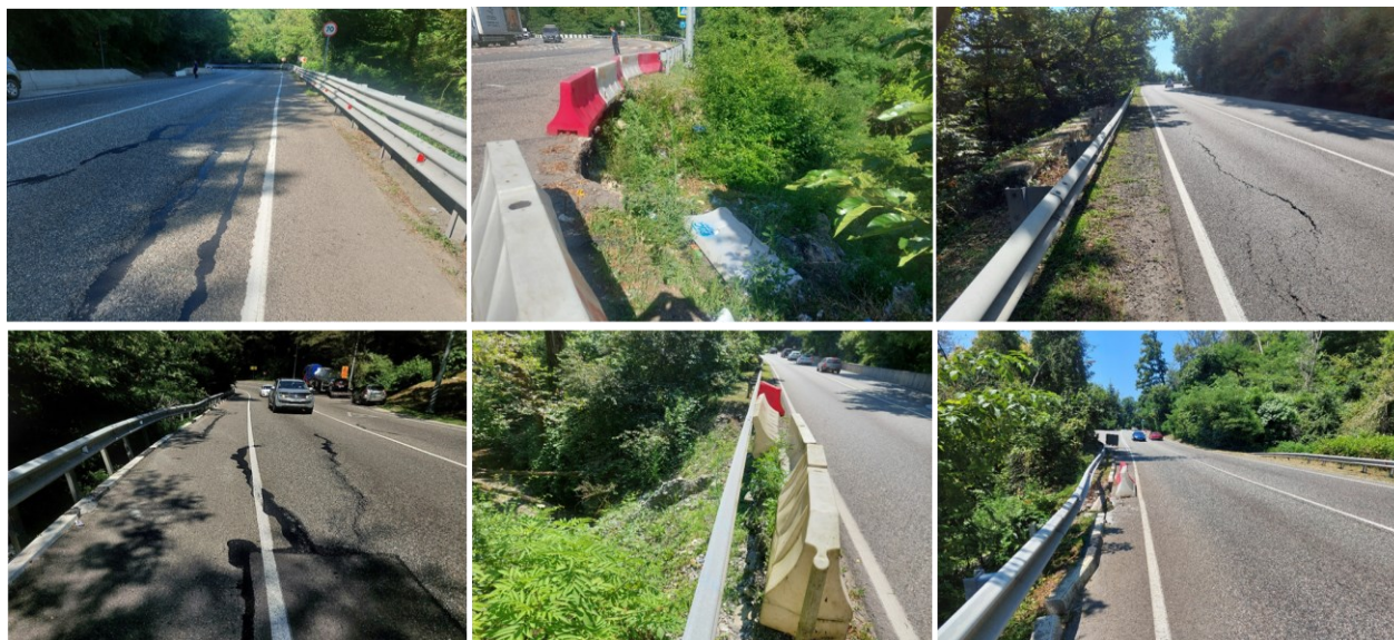
Рис. 2. Визуальное обследование удерживающего сооружения и оползневого участка Fig. 2. Visual inspection of the retaining structure and landslide area
