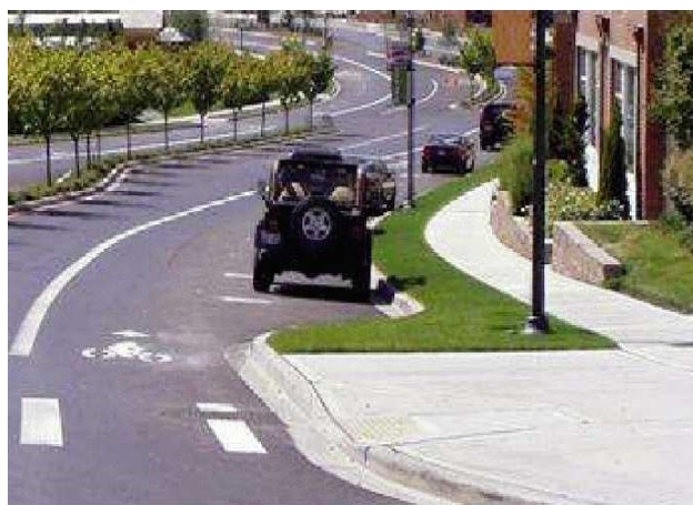
Рис. 9. Примеры выступов бордюров на перекрестке [13] Fig. 9. Examples of curb protrusions at an intersection [13]
