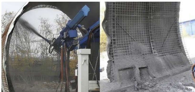
Рис. 1. Создание объёмной конструкции по металлическому армокаркасу Fig. 1. Creating a three-dimensional concrete structure based on a metal frame
