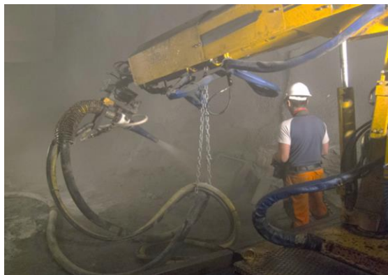
Рис. 2. Набрызгбетонирование «мокрым» способом Fig. 2. Wet spray concreting
