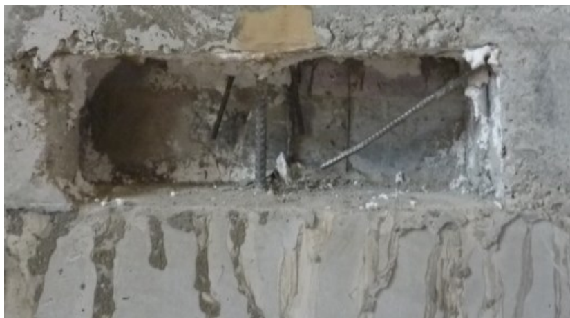
Рис. 14. Герметичный шов при соединении металлической гидрошпонки на силиконовом герметике
