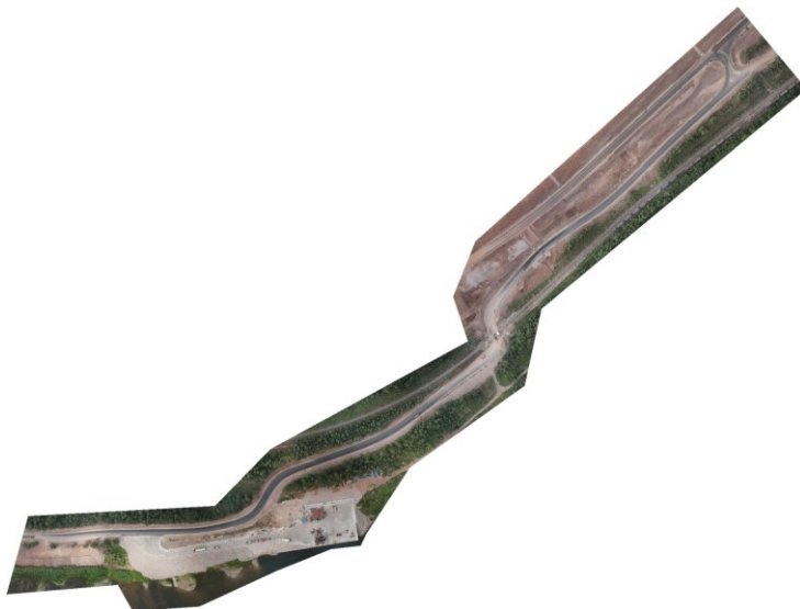
Рис. 4. Участок федеральной автомобильной дороги «Вилюй», расстояние 1,3 км
