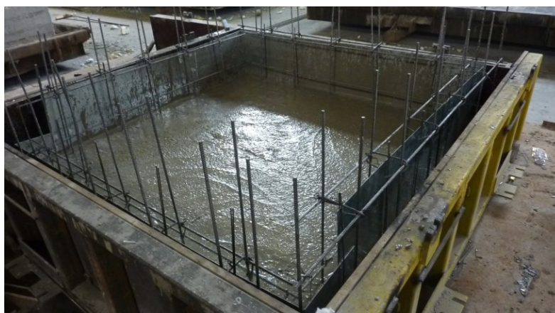
Рис. 5. Образование технологического шва Г3 и Г4 (рис. 4, разрез Б-Б) Fig. 5. Formation of technological seam G3 and G4 (fig. 4, section Б-Б)
