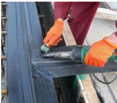
Рис. 3. Процесс сварки поливинилхлоридной гидрошпонки Fig. 3. Polyvinyl chloride waterstop welding process
